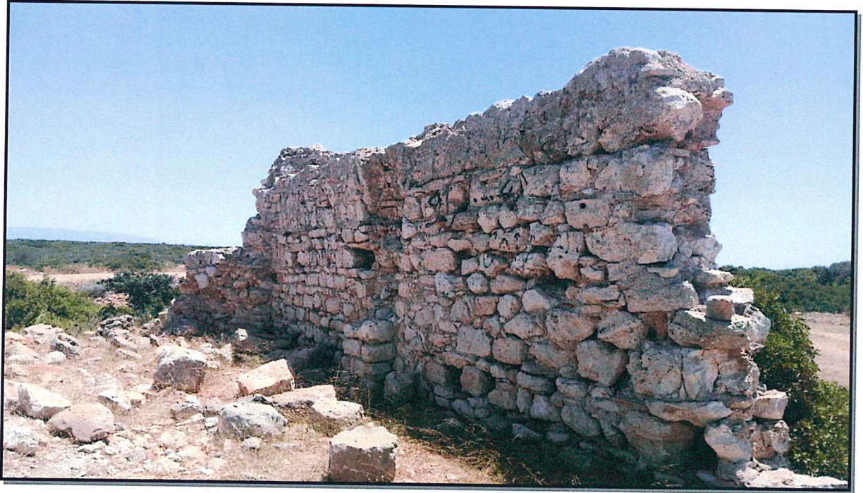
875 Ada 3 parsel üzerinde bulunan şapel kalıntısından görünüm
