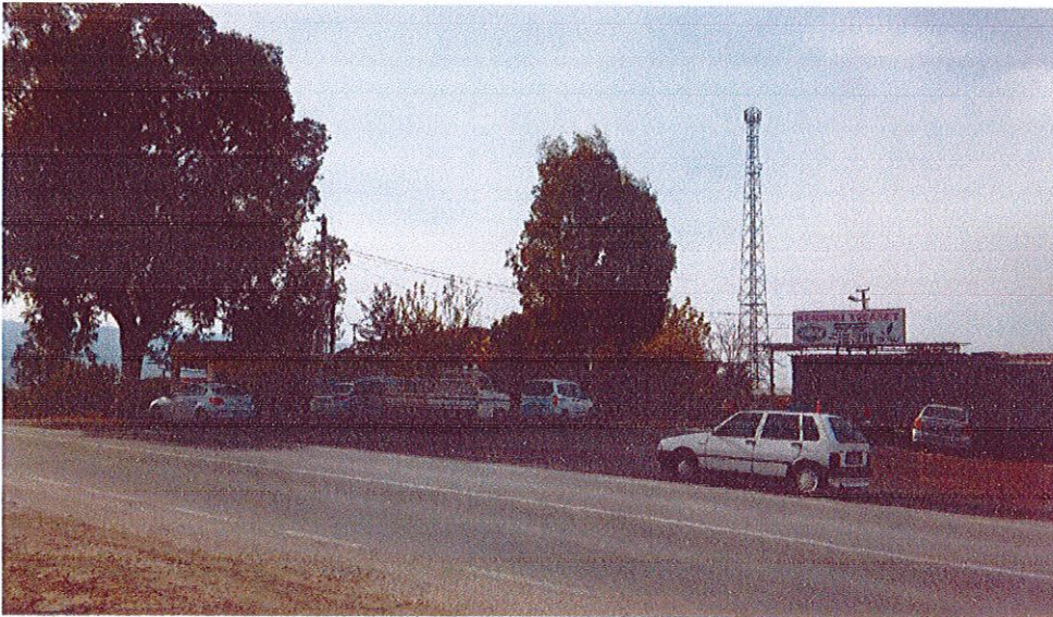
Resim 15: Alanın Batı Yönünde Zeytin Depolama Yapıları
